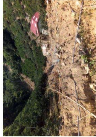
樹園地の崩壊とパイプライン、農業用モノレール、小屋の損壊 （愛媛県宇和島市）
